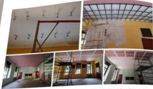
Figura 3 - Installazione di pannelli pendolari e estensibili multifunzionali antiriflessione Ecoson Master F in aule.
